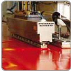
HF Schweißarbeiten high frequency application
